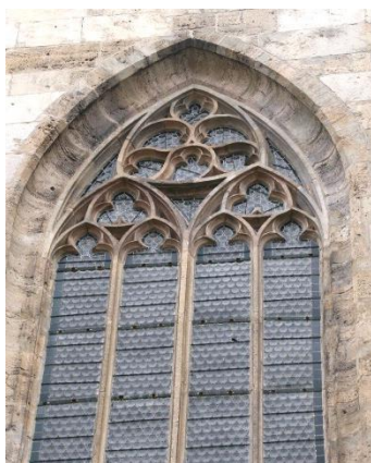
Abb. 12: Gotisches Fenster mit Fischblasenwerk
