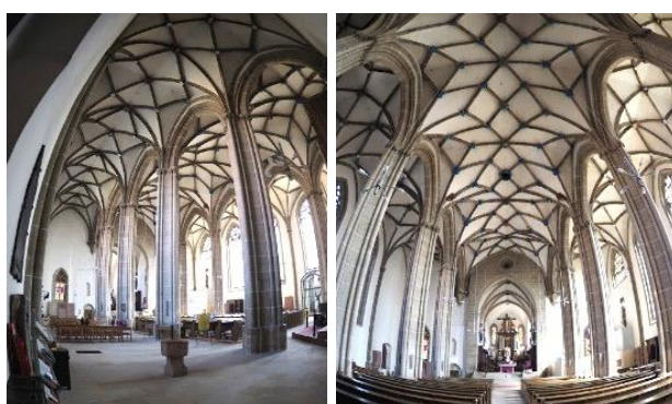
Abb. 9: Netzgewölbe des linken Seitenschiffes (links); Sterngewölbe des Hauptschiffes (rechts)
