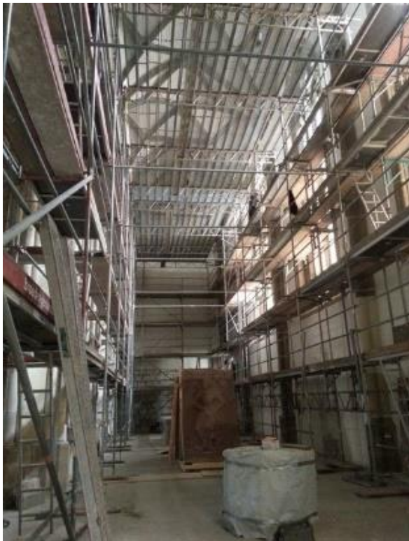
Abb. 39: Baugerüst im Dom bei den derzeitigen Renovierungsarbeiten
